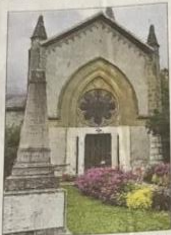
Les travaux vont commencer par la rénovation de la façade. Photo Le DL/L.F.
